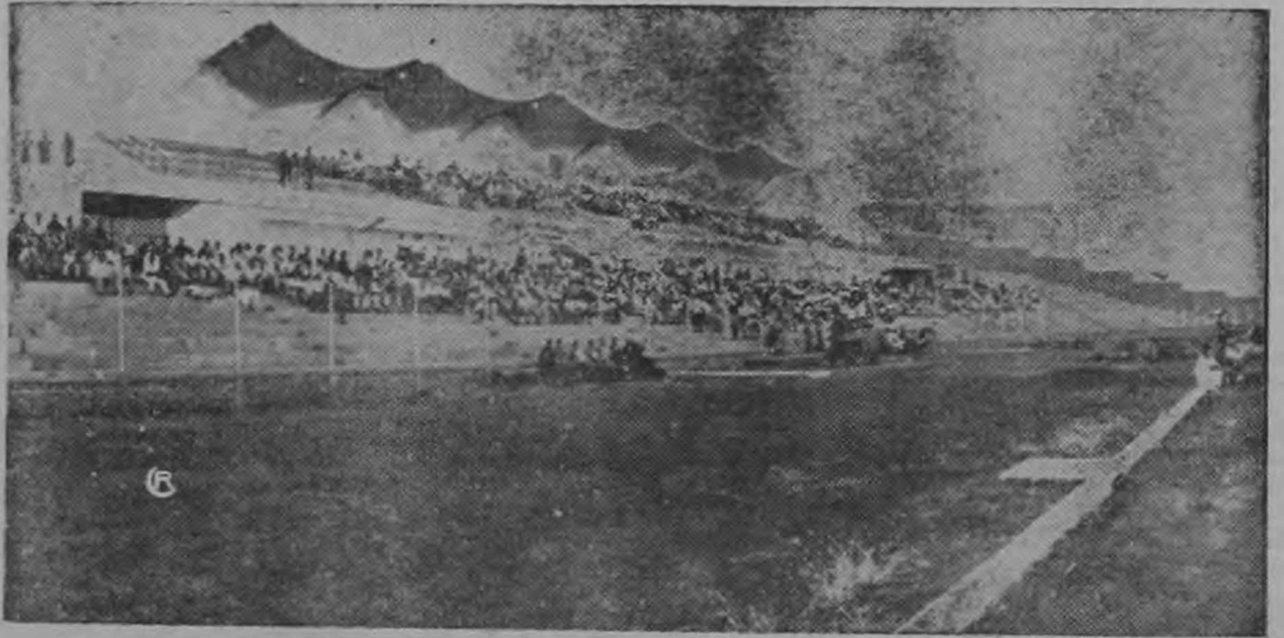
Estadio "El Palmar" de Santa Ana ha sido reconstruido magníficamente para el Campeonato Centroamericano - Norte y del Caribe que se inaugura hoy. Lo más atractivo, es la gradería de sombra que ha sido montada en forma de ondas.
